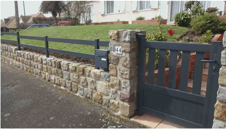
Clôture en aluminium sur mur-bahut en pierre naturelle, hourdée au mortier, réalisé en soutènement d'un jardin en pente
